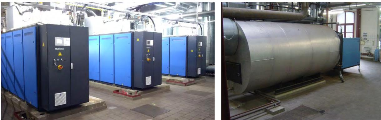
Abb. 17/18: BHKW-Module und Warmwasserkessel im Kesselhaus
