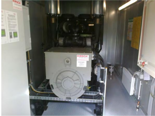
Abb. 19: Notstromaggregat bei Haus 4
