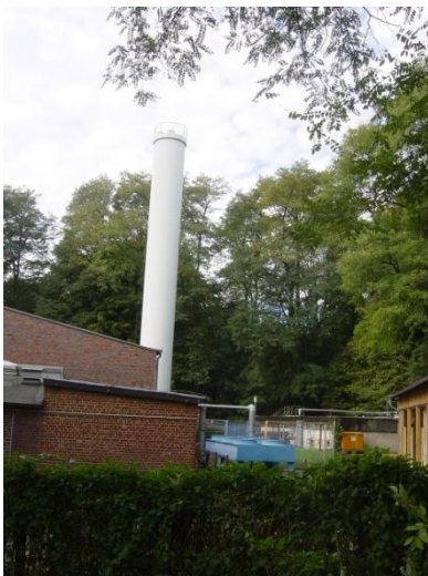
Abb. 25: Kamin des Kesselhauses
