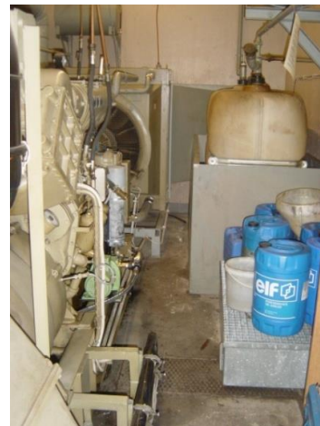
Abb. 20: Notstromaggregat im Haus 14
