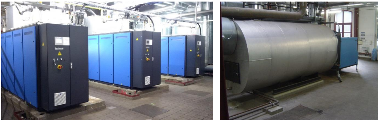
Abb. 17/18: BHKW-Module und Warmwasserkessel im Kesselhaus
