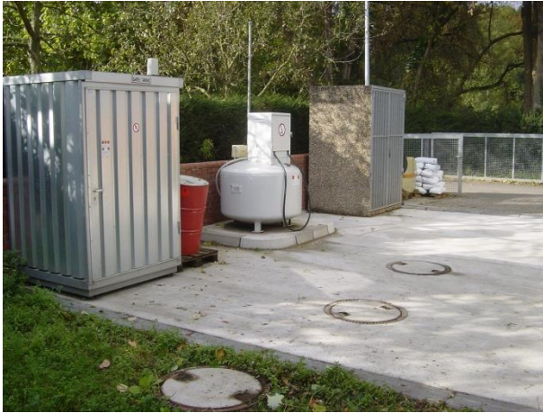
Abb. 27: Waschplatz mit Betankungs- und Abscheideranlage an der Gärtnerei
