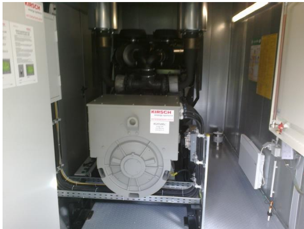
Abb. 19: Notstromaggregat bei Haus 4
