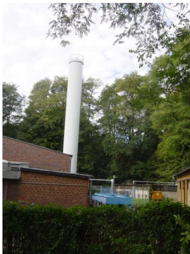
Abb. 3: Kamin des Kesselhauses
