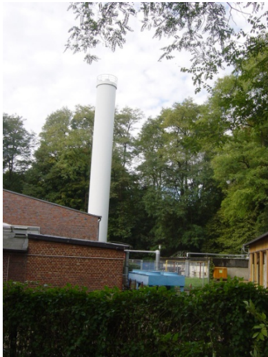
Abb. 3: Kamin des Kesselhauses
